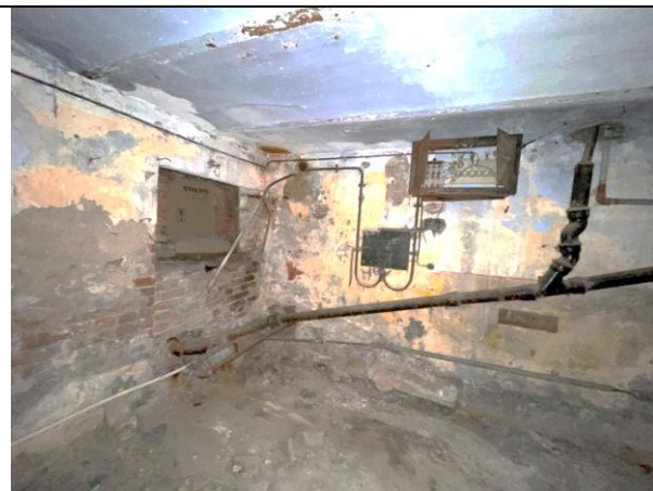
Фото 29. Типичное состояние Объекта оценки
